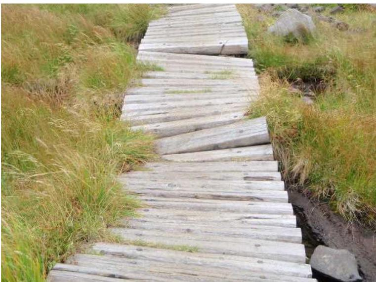
経年劣化により土台が腐食し床板が波打っている
