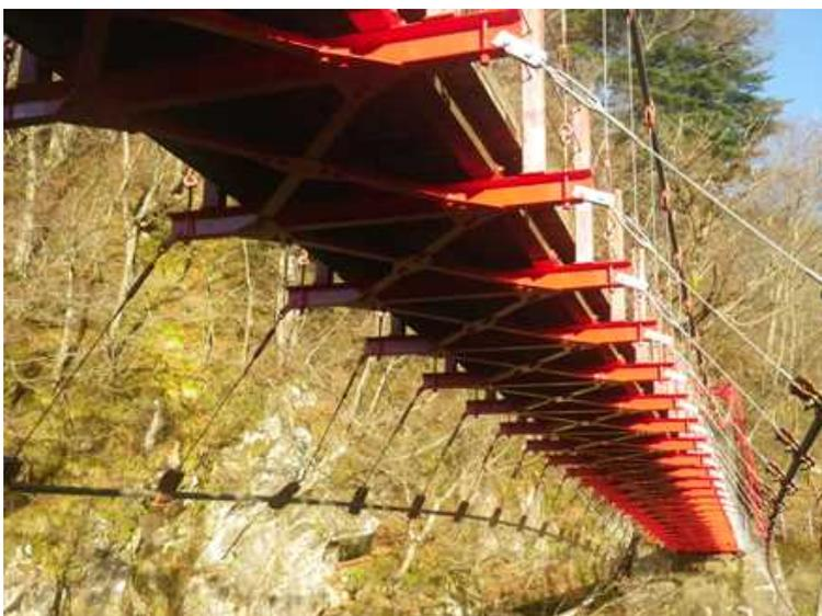
R5 横桁・横溝 塗装完了
